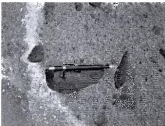
Fotografía N° 3: Se puede establecer que el tamaño del material granular es de aproximadamente de 120 mms, correspondiente al kilómetro 1,240.
