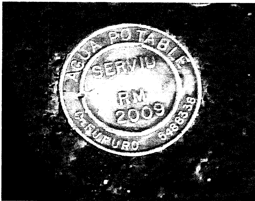
Foto N°s 20 y 21 – Tapas de cámara de agua potable
