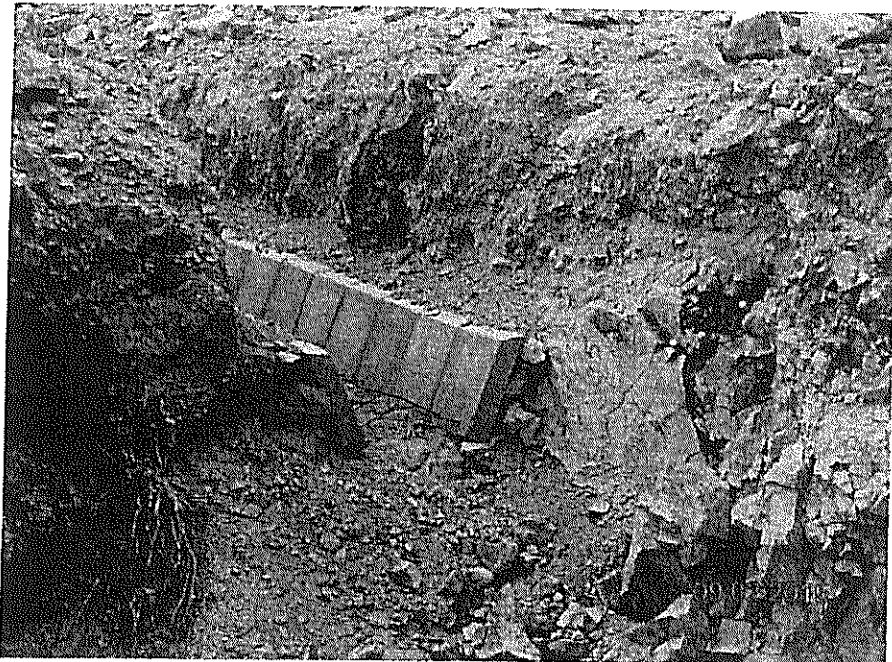
Fotografía N° 4, 2 de septiembre de 2015, foso revestido no terminado en el km 160,540.
