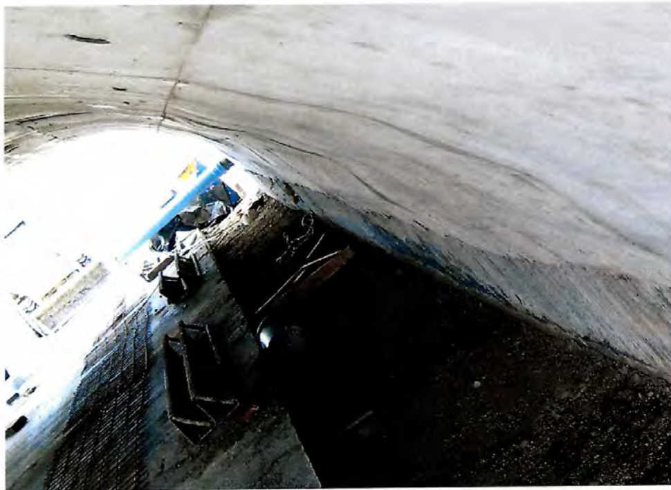
Foto N° 8: Irregularidades superficiales bajo losa de puente.
