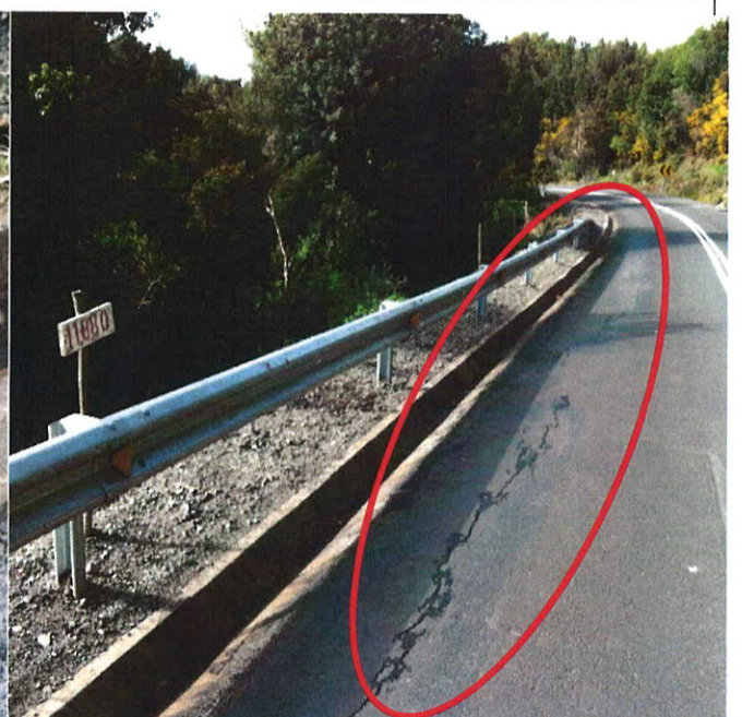
Fotografía N° 8: Restitución descenso terraplén Km 11.860.
