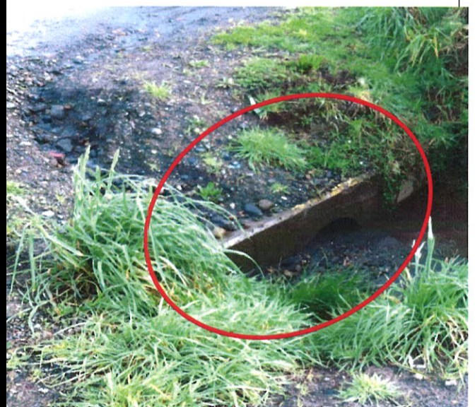
Fotografía N° 2: Obra de arte longitudinal embancada Km 1.067.
