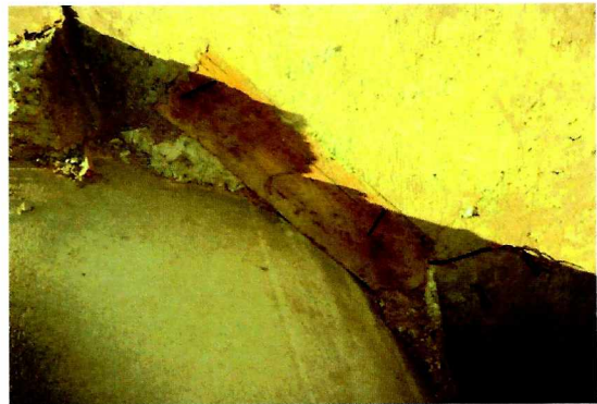
Fotografía N°30: Madera incorporada en boca de muro.
