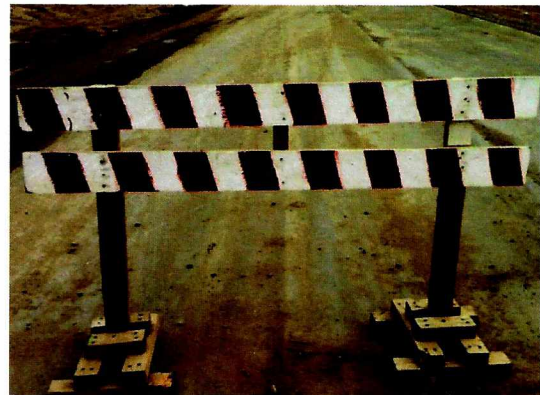
Fotografía N° 4: Barrera Tipo II sin colores retroreflectantes.
