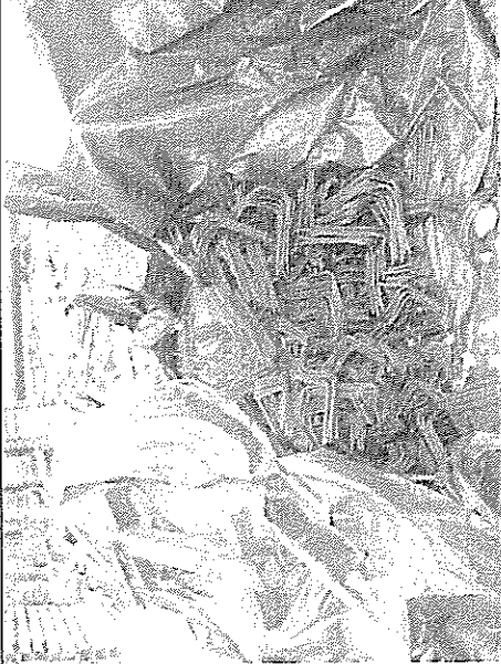
Fotografía N°13: Acero de refuerzo acopiado sobre losa de muelle, sin techo.
