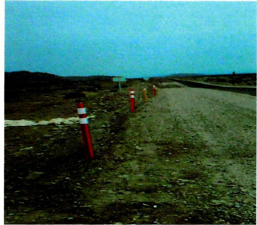
Fotografía N° 8: Cilindros con soportes no seguros
