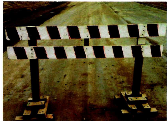
Fotografía N° 4: Barrera Tipo II sin colores retroreflectantes.
