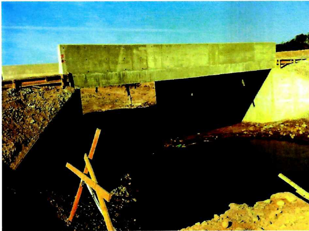
Fotografía N° 21: Losa puente - emplazamiento.
