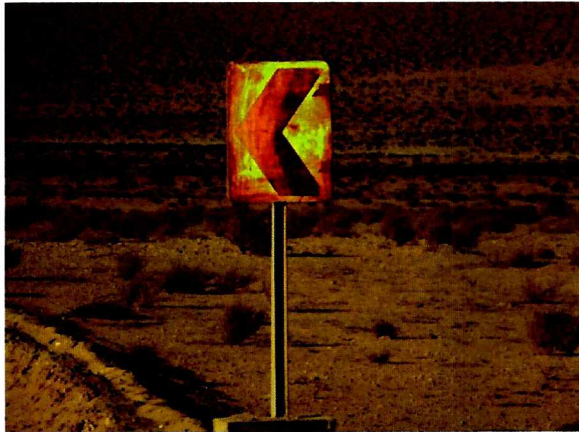
Fotografía N° 25: Delineador direccional sin retroflexión.
