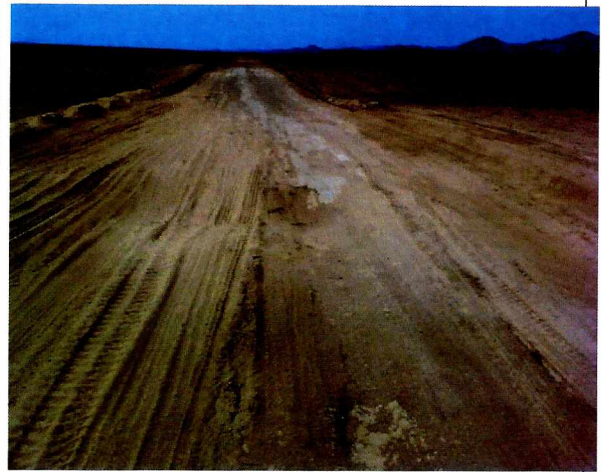
Fotografía N° 2: Desvío provisorio Dm. 32.720.
