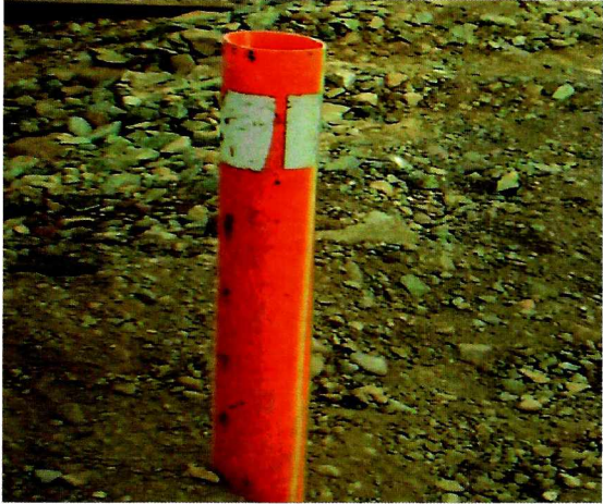
Fotografía N° 7: Cilindro de tránsito con deterioro.
