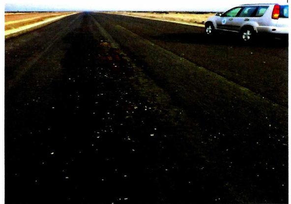
Fotografía N° 12: Pavimento con exudación.
