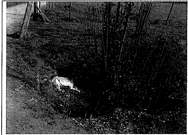
Fotografía N°37: Exceso de vegetación y animales muertos en foso izquierdo, kilómetro 18, camino rol G-18. (20-08-2013)
