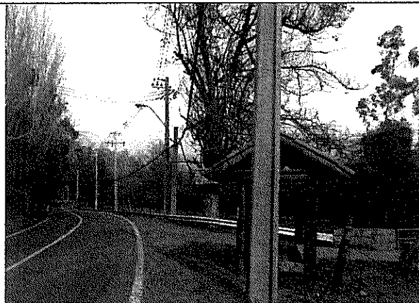
Fotografía N°41: Defensa caminera sin elementos reflectantes, oxidada y dañada, cercano a kilómetro 17,8, camino rol G-27. (19-08-2013)
