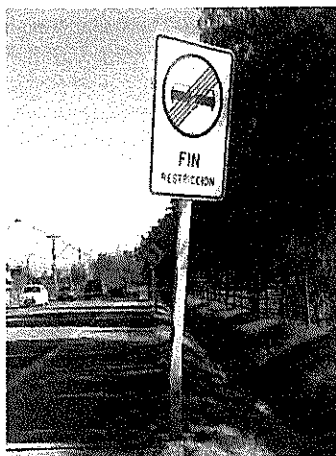
Fotografía N°17: Señalética "fin restricción" girada y con poste dañado, cercano a kilómetro 42, camino rol G-16. (09-08-2013)
