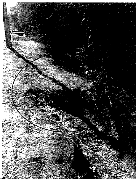
Fotografía N°23: No se mantiene la sección del foso, entre kilómetros 20 a 21, camino rol G-30. (14-08-2013)
