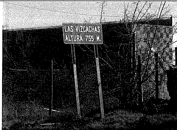
Fotografía N°11: Señalética vertical con placa oxidada y mal posicionada, cercano a kilómetro 14,3, camino rol G-25. (13-08-2013)
