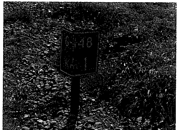
Fotografía N°2: Provincia de Chacabuco, ruta G-148, baliza de placa 1 km doblada. (19-08-2013)
