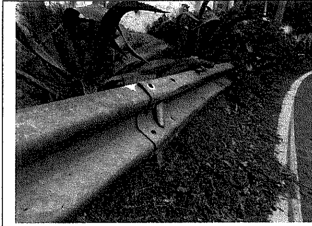
Fotografía N°37: Defensa caminera sin pernos, cercano a kilómetro 16,8, camino rol G-27. (19-08-2013)
