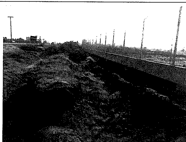
Fotografía N°30: Exceso de vegetación en foso derecho, kilómetro 15, camino rol G-18. (20-08-2013)
