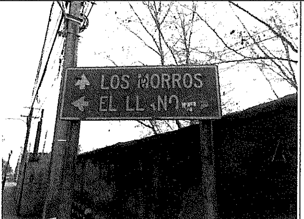
Fotografía N°18: Señalética vertical con leyenda incompleta y rayas, cercano a kilómetro 8,9, camino rol G-27. (19-08-2013)
