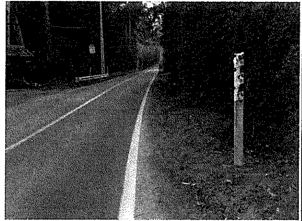
Fotografía N°50: Detalle hito vertical sin placa, cercano a kilómetro 18, camino rol G-27. (19-08-2013)
