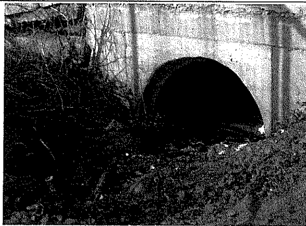
Fotografía N°29: Alcantarilla sin su sección libre en un 90%, cercano a kilómetro 13,5, camino rol G-18. (20-08-2013)
