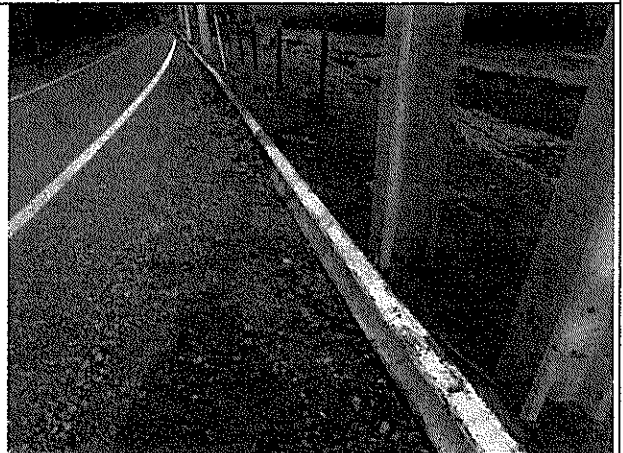
Fotografía N°42: Defensa caminera sin elementos reflectantes y oxidada, cercano a kilómetro 17,8, camino rol G-27. (19-08-2013)
