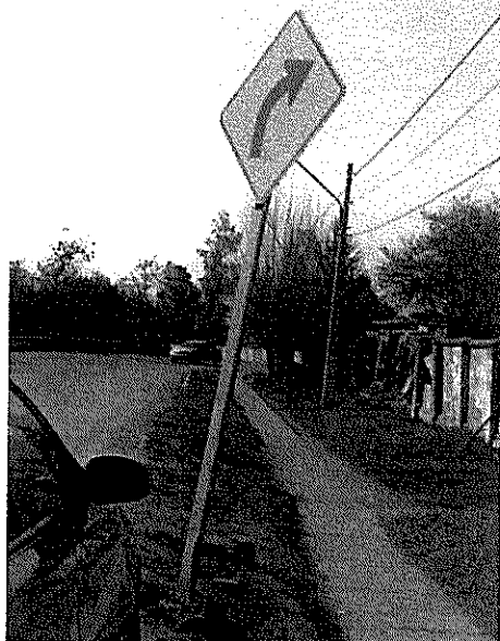
Fotografía N°8: Señalética "curva a la derecha" girada y con poste dañado, cercano a kilómetro 38, camino rol G-16. (20-08-2013)
