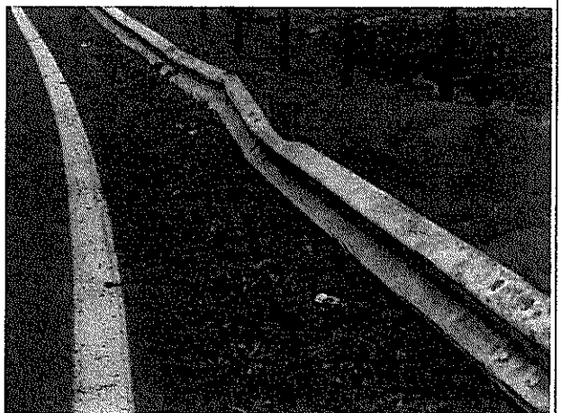
Fotografía N°48: Defensa caminera dañada, cercano a kilómetro 17,8, camino rol G-27. (19-08-2013)
