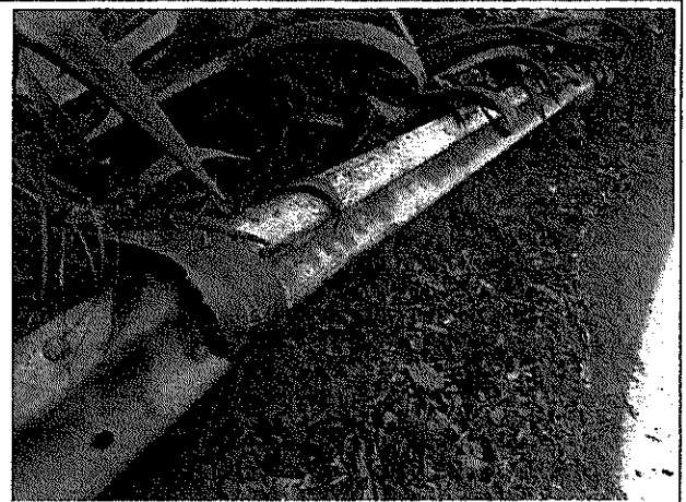
Fotografía N°38: Defensa caminera oxidada, cercano a kilómetro 16,8, camino rol G-27. (19-08-2013)
