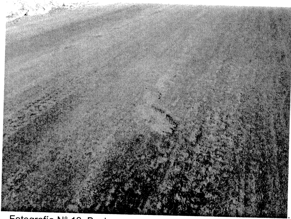
Fotografía N° 12. Baches en calzada en Ruta B-800, km 1,04.
