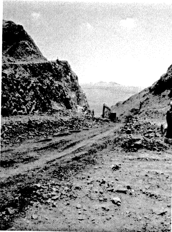
Fotografía N° 9. Excavación en corte con maquinaria, Ruta 268, km 12,4.
