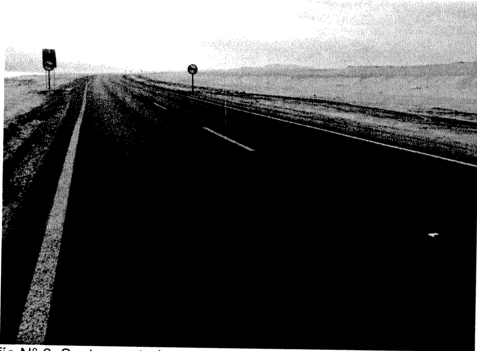
Fotografía N° 8. Sector posterior a curvas con tachas reflectantes a más de 12 m. entre sí, Ruta B-440.
