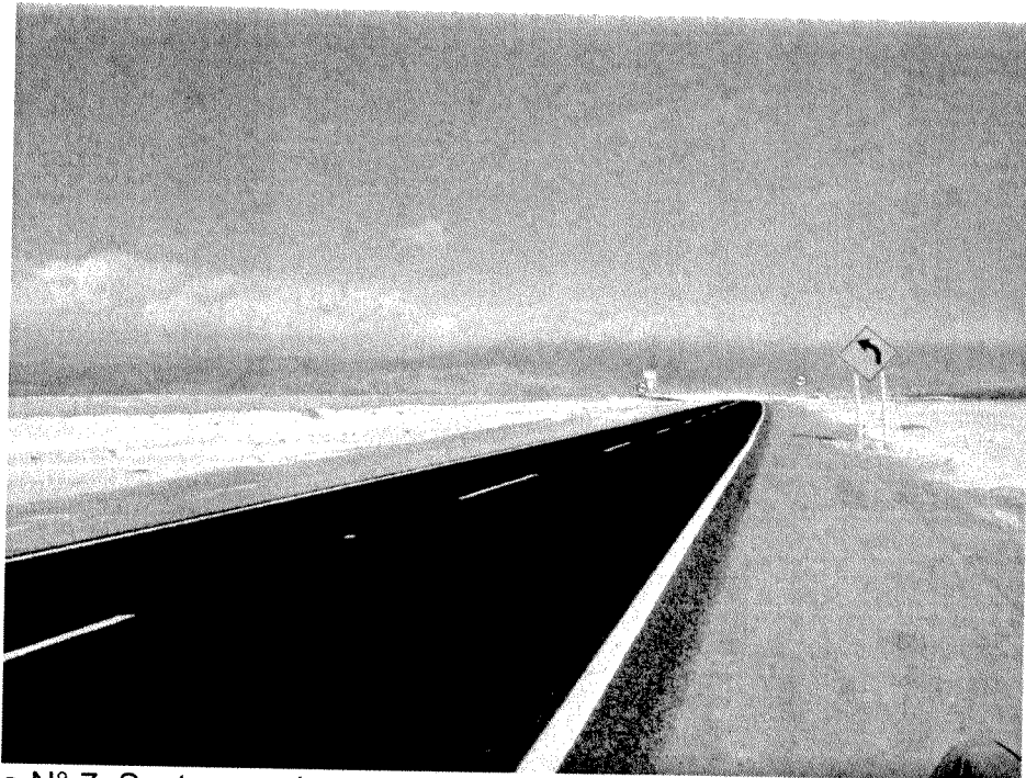
Fotografía N° 7. Sector previo a curvas con tachas reflectantes a más de 12 metros entre sí, Ruta B-440.
