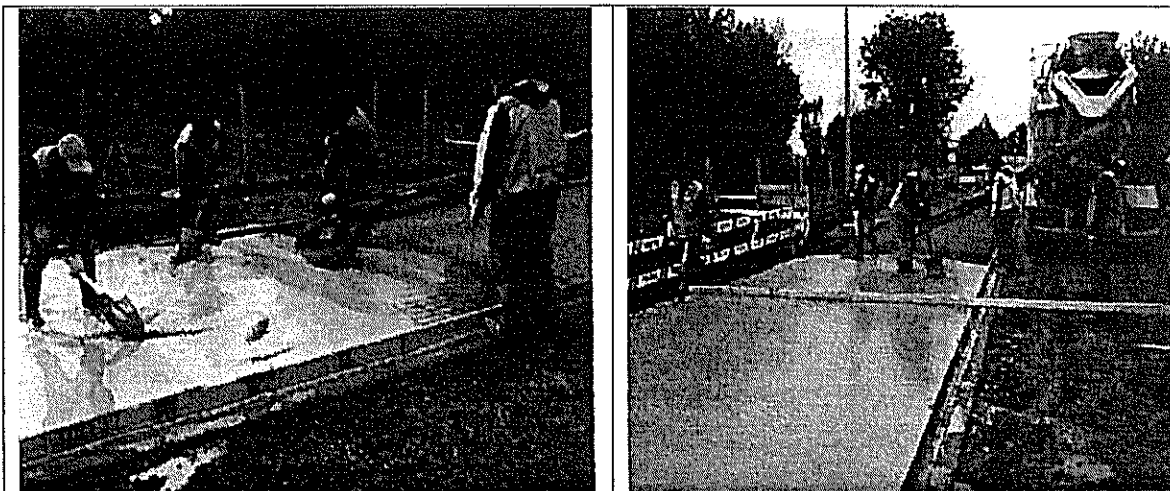
Faenas de terminación superficial.
