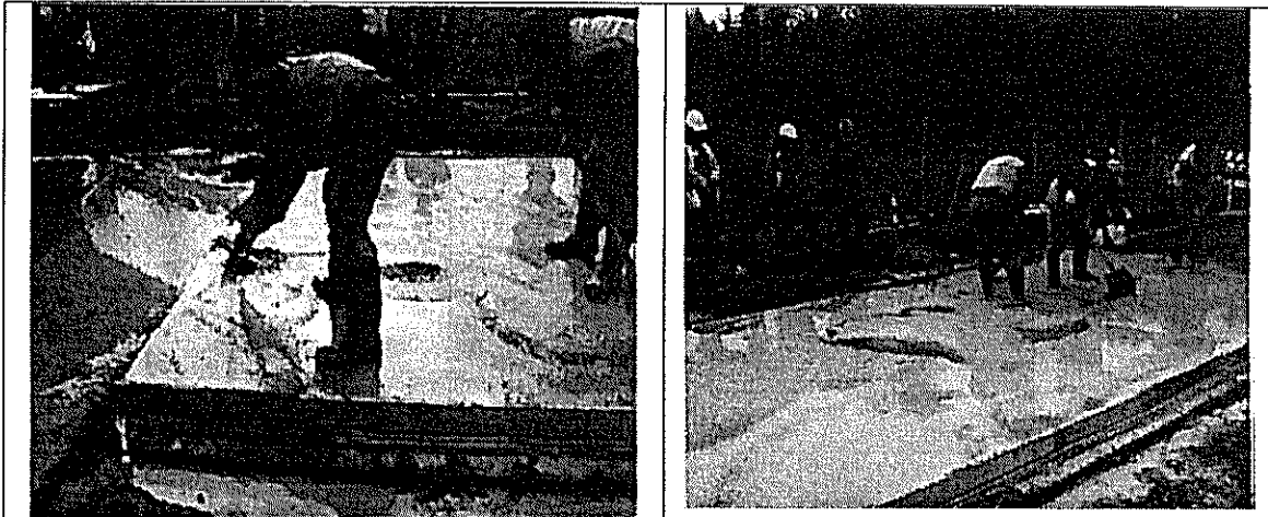
Faenas de esparcimiento del hormigón.
