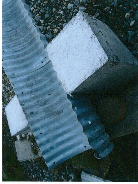
Fotografías N°s 9 y 10: Descargas de agua en tubos corrugados de media caña, D = 0,60 m
