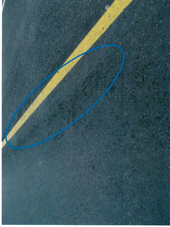
Fotografía N° 17: Concreto asfáltico de rodadura.
