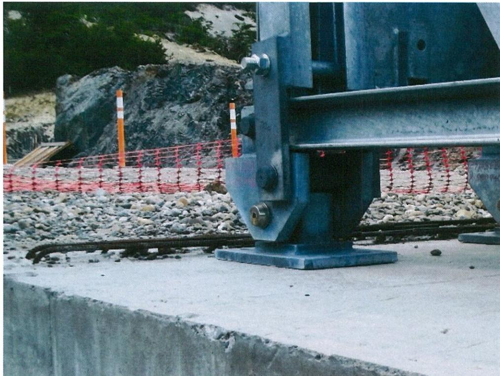
Fotografía N° 2: Enfierraduras dobladas en la losa de apoyo del puente
