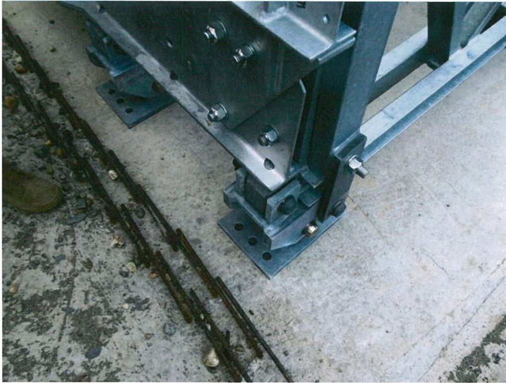
Fotografía N° 3: Enfierraduras dobladas en la losa de apoyo del puente
