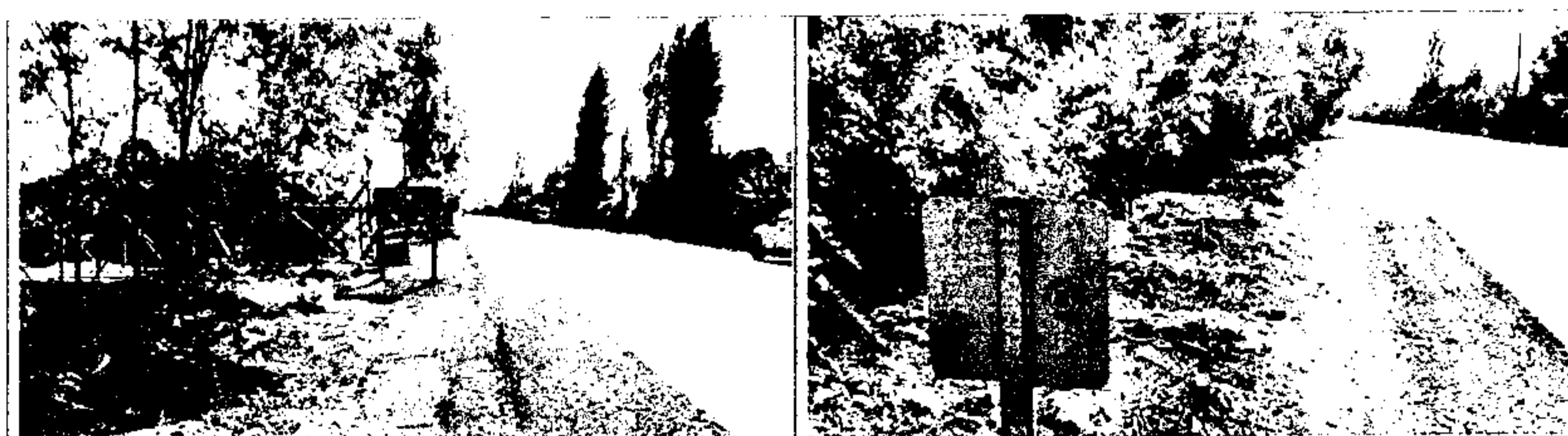
Deslinde desde el Km 9.860 a 10.100, se observan las puertas de acceso ubicadas en el deslinde correspondiente al camino Parral a la Montaña o Ruta L-751.
