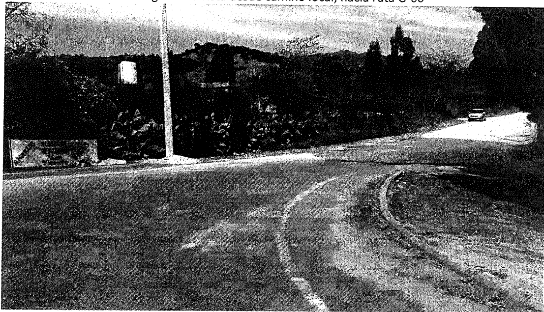
Fotografía 2: Enlace entre Ruta G-66 y camino Local. (Km 78 de la Ruta G-66)
