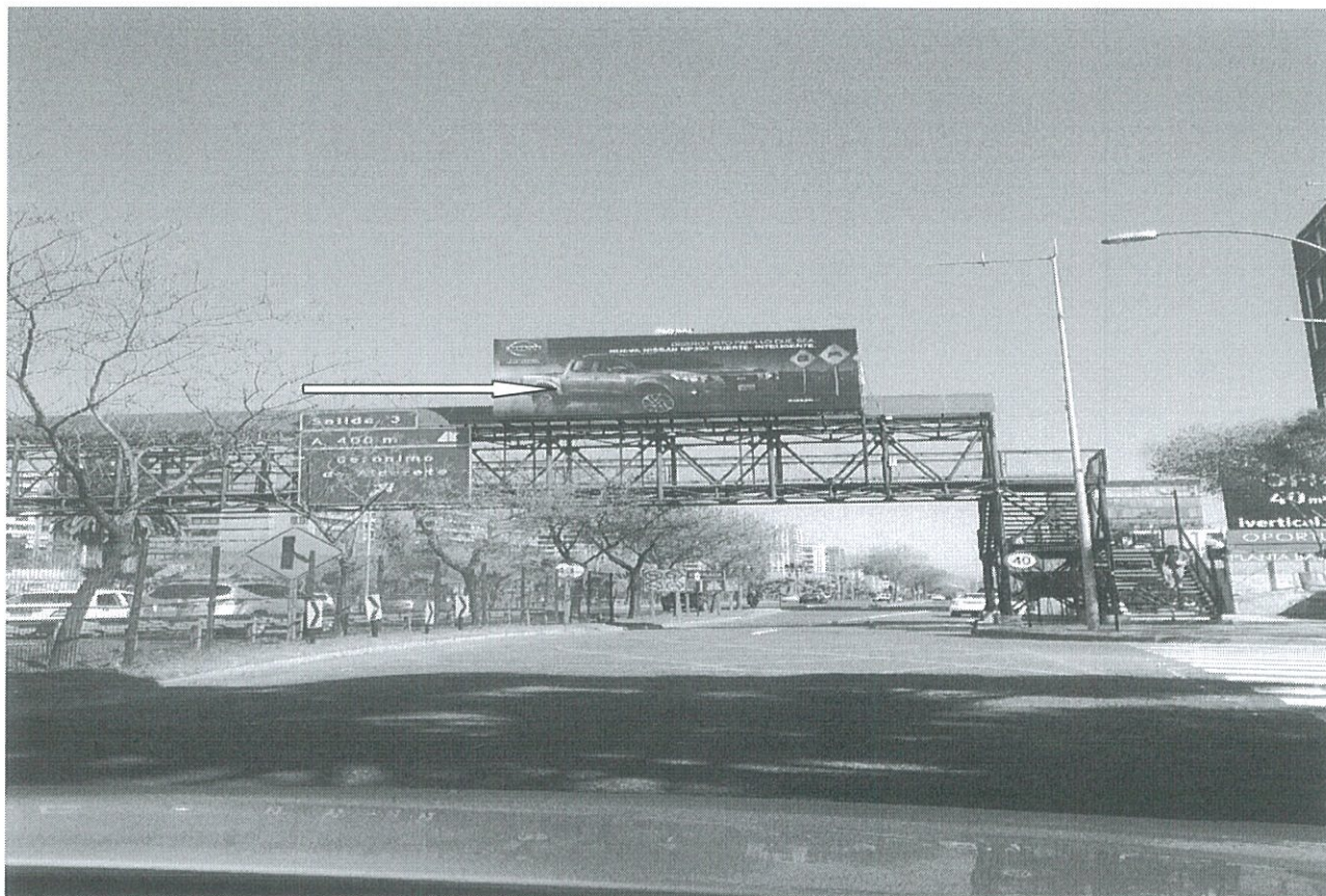
AV. KENNEDY, KM. 2.300, sentido Ascendente.
