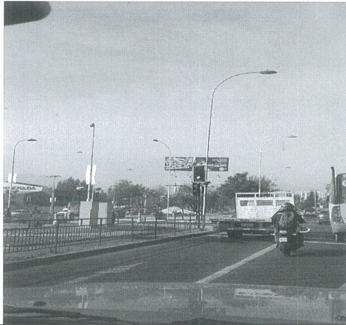
G-25 (La Florida), km.4.500 , sentido ascendente contramano
